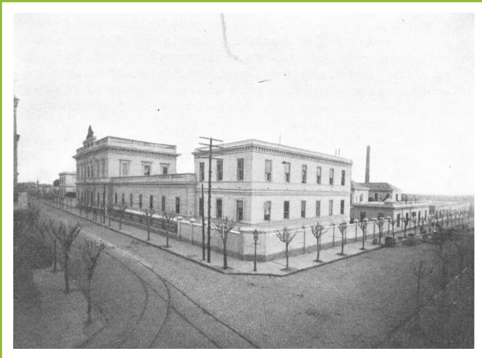
Ospedale nuovo. Veduta generale da Gazcon angolo Cangallo Società Italiana di Beneficenza in Buenos Aires. La storia dell' Ospedale Italiano; Buenos Aires 14 de Settembre 1853 -8 dicembre 1922. Buenos Aires; 1923. p. 49
