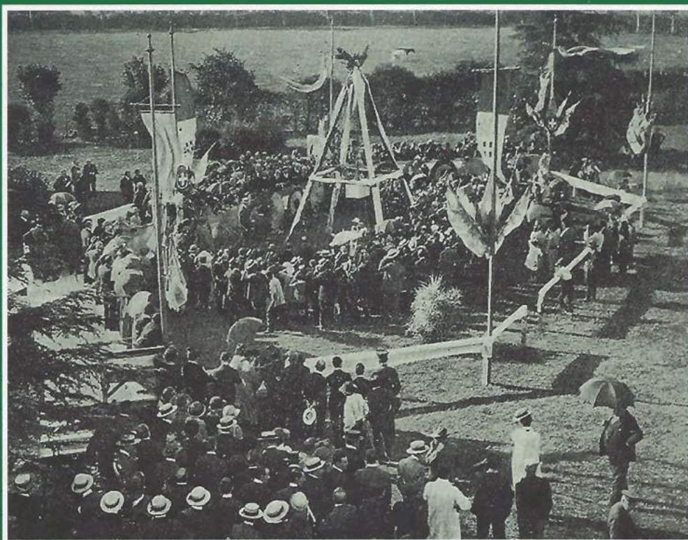
Posa della pietra donfamentale dell'asilo Cronici in San Justo (F.C.O.) il 10 Dicembre 1922. Vista d'insieme.
